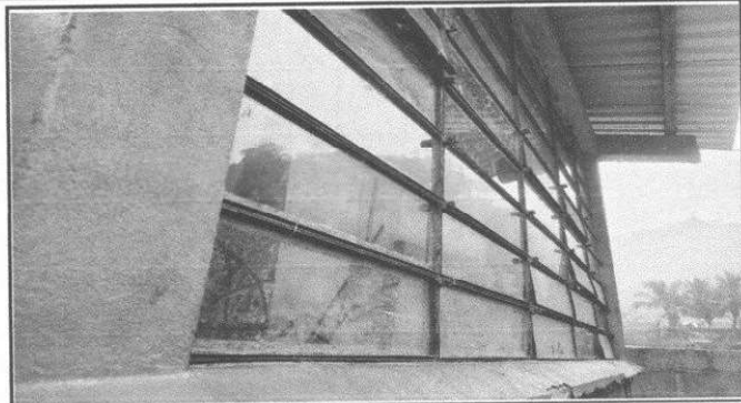
Foto 2: Se observa la finalizacion del cambio de la ventana de la escuela.
