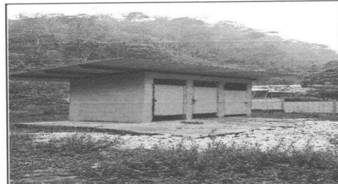
Foto 4: Se observa la finalizacion de la pintada y repacion de puerto y techo.
